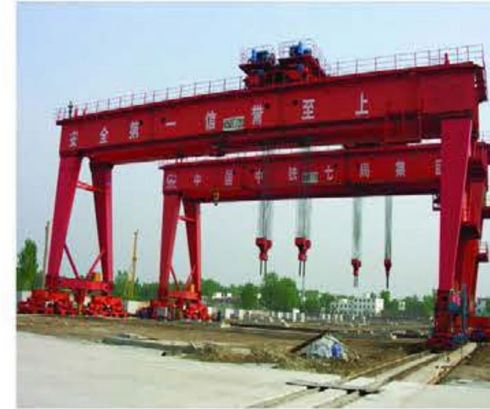
中铁七局施工现场 CRSG construction site
